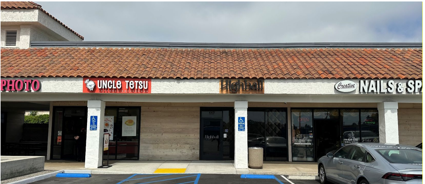
1. Existing tenant frontage - front entrance
