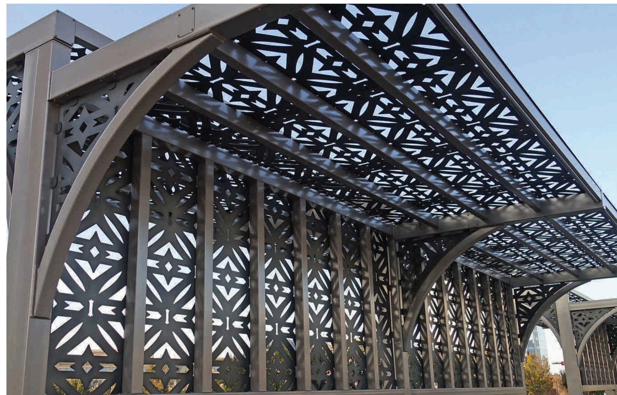
OPTION A: VERTICAL & HORIZONTAL LASER-CUT STEEL OPCIÓN A: ACERO VERTICAL Y HORIZONTAL CORTADO CON LÁSER
