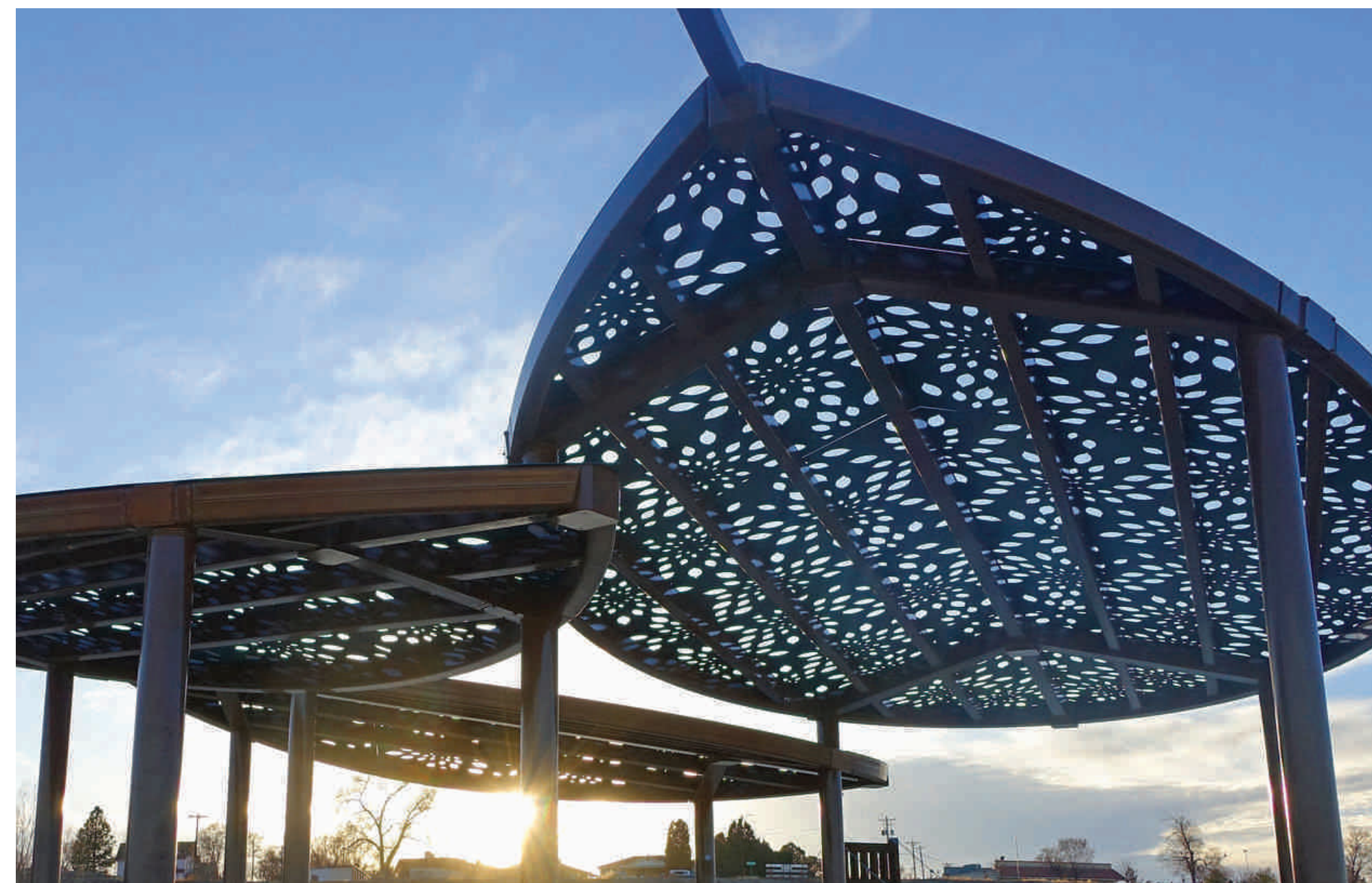
OPTION B: STAGGERED HEIGHT LASER-CUT STEEL LEAF OPCIÓN B: HOJA DE ACERO CORTADA POR LÁSER EN ALTURA ESCALONADA
